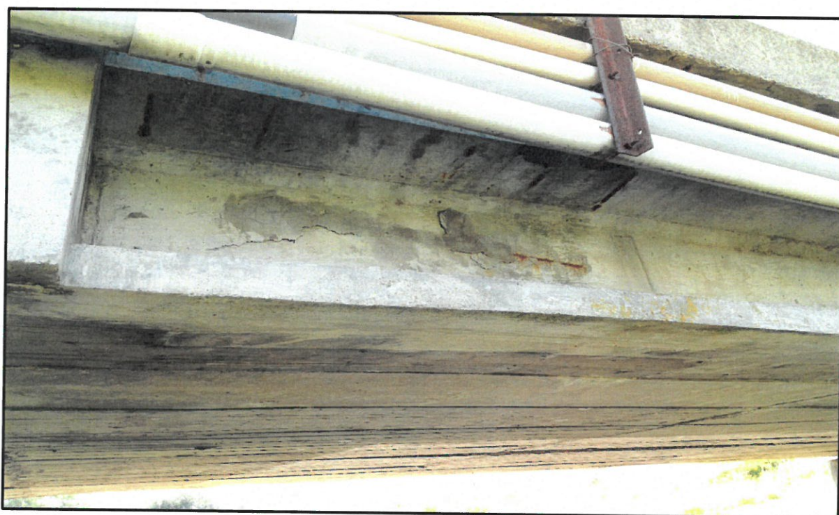
Foto nr. 4 – Suspendarea a 4 conducte PVC pe partea laterala a suprastructurii
